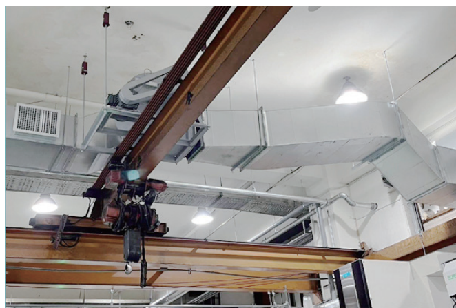
設置全廠區空氣循環設備
